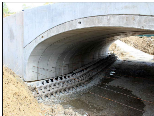
A-JACKS PARTIAL INVERT N.T.S.
