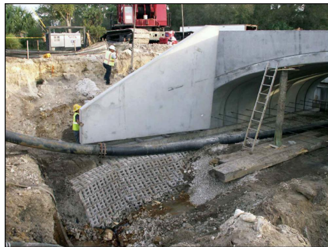
ARMORFLEX PARTIAL INVERT N.T.S.
